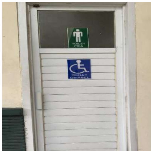
Toilet khusus difabel
